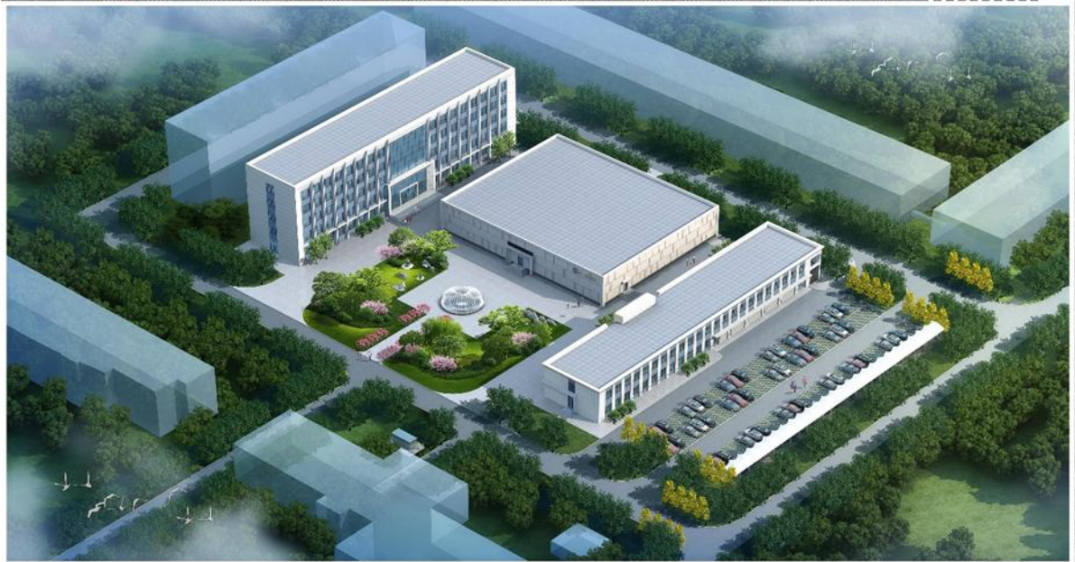
宁夏和宁化学有限公司运行控制中心项目鸟瞰图
